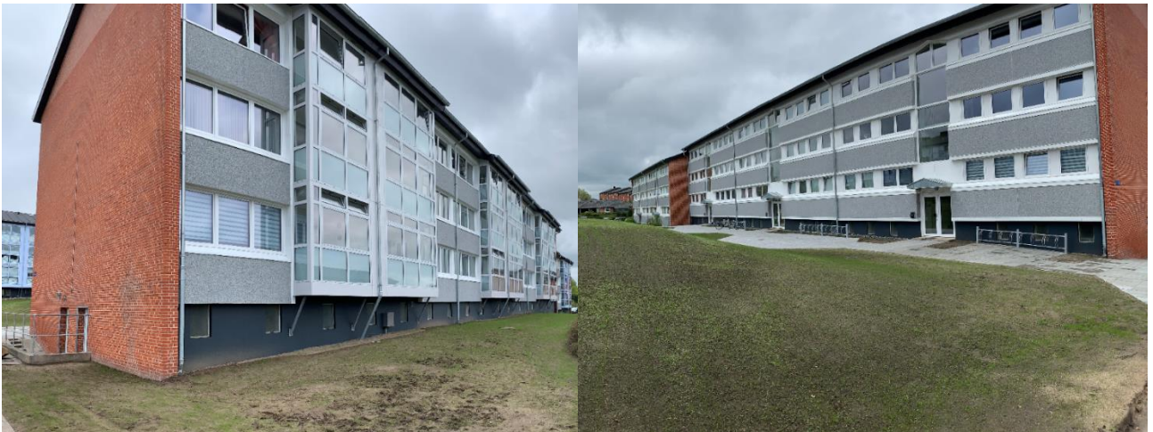
Renovering efter branden i Stoldal
