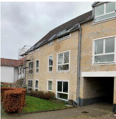
Nye vinduer Morellgade
